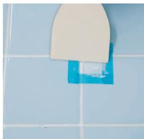
3 割れている部分にコーキング剤をヘラで埋め込むようにして塗り込みます。乾く前に不要なコーキング剤を拭きとり、マスキングテープを剥がします。
