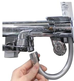
まずヘッドとホースを手で外し、次に混合水栓とホースを接続しているねじをウォーターポンププライヤーなどで外します。新品を逆の手順で取り付けます。
