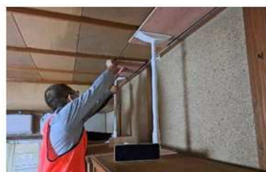
家具転倒防止器具の取り付け
