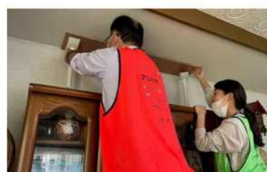
家具転倒防止器具の取り付け
