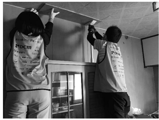
転倒防止器具の取り付け
