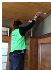
当て板の挿入
